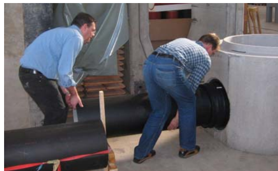
Bild 4: Einschieben der Rohres mit aufgesteckter Muffe in den Adapter
