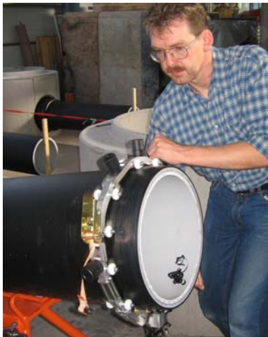
Bild 2: Entfernung der Oxidhaut Bild 3: Rohr mit aufgesteckter Schweißmuffe
