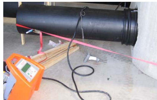
Bild 5: Elektroschweißung des Schachtanschlusses
