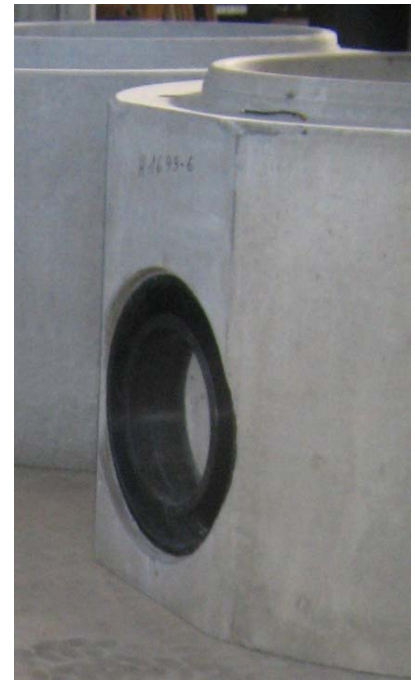
c) In den Schacht integrierter und verankerter Adapter
