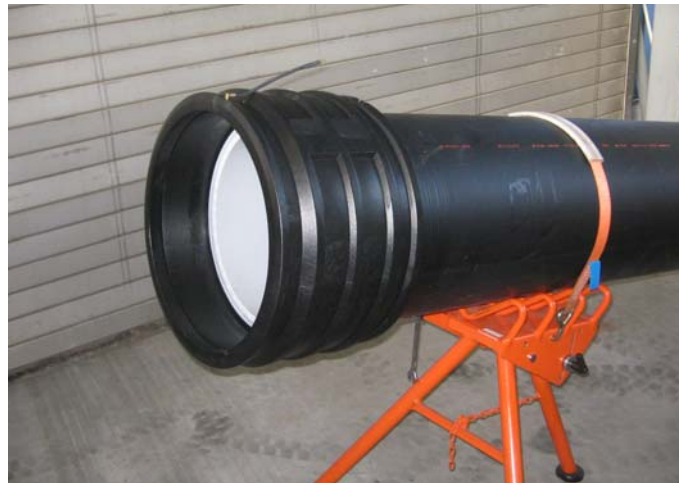
Bild 2: Entfernung der Oxidhaut Bild 3: Rohr mit aufgesteckter Schweißmuffe
