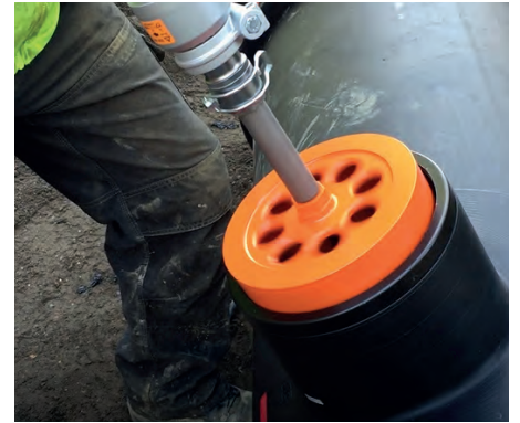
3. Anbohrung/Prüfung
