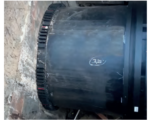
3. Der fixierte PE-Rohrstrang
