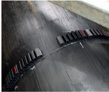
2. Flex-Fixierblock verschweißt
