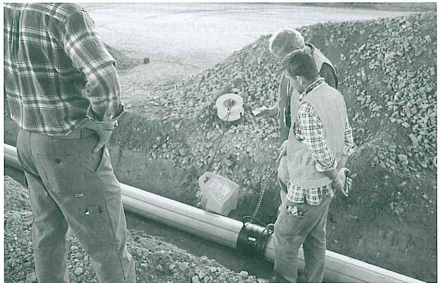
Sämtliche Rohrleitungen wurden vor dem Verfüllen und Verdichten vorschriftsmäßig auf Dichtheit geprüft.
