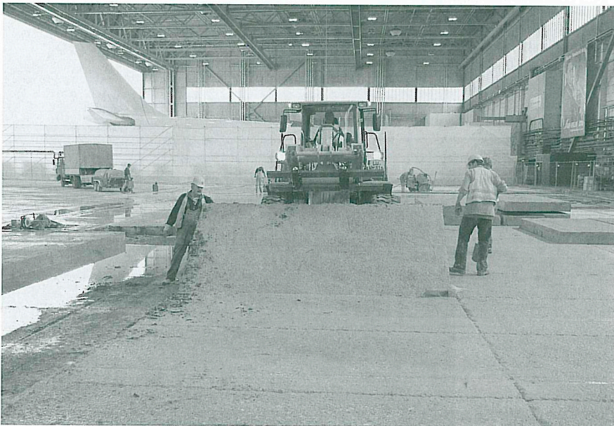
Ganz vorsichtig und gut gewässert wird im LTU-Hangar auf dem Düsseldorfer Flughafen die alte Betondecke in kleinen Teilen abgetragen, um die Flugzeuge nebenan nicht unnötig zu verschmutzen.
