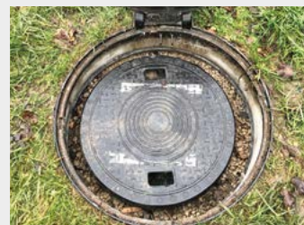
Dichtfunktion durch PE-Deckel DN 625 verhindert das Eindringen von Wasser, auch in Überflutungsgebiete.
