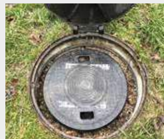
Dichtfunktion durch PE-Deckel DN 625 verhindert das Eindringen von Wasser, auch in Überflutungsbereichen
