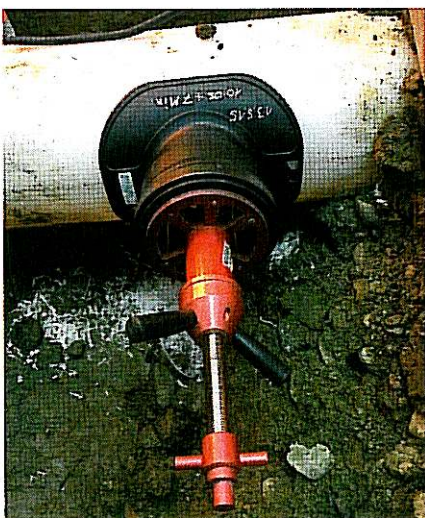
Bild 2: PLASSON LightFit Anschluss-Sattel mit PVC/KG/PP Übergang, Typ dA 280-355 x 160 mm, montiert und verschweißt auf PE-Liner dA 300 mm und KG-Anschlussleitung DN 150
