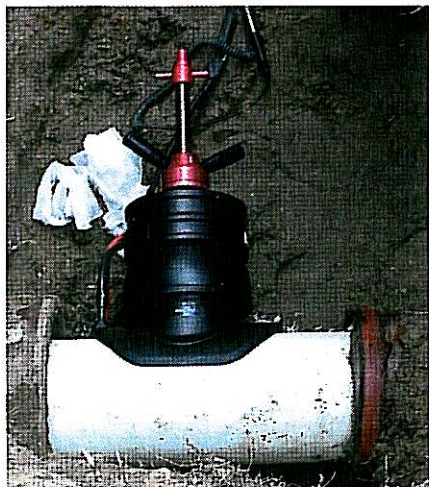
Bild 3: Anschluss-Anbindung und Ausrichtung leicht gemacht: PLASSON LightFit Anschluss-Sattel mit flexibler Anschlussmuffe, Typ 280-315 x 160 mm, montiert und verschweißt auf PE-Liner dA 300 mm einschließlich Anbindung der PE-HD Hausanschlussleitung dA 160 mm
