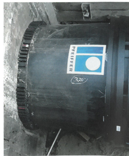
Abb. 4 – Der fixierte PE-Rohrstrang
