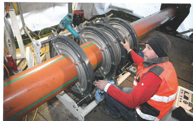
Bild 2: Auf perfekte Schweißwülste wurde bei diesem Projekt besonders geachtet. Die Schutzmantelrohre wurden millimetergenau in den Spannbacken der Schweißmaschine ausgerichtet und glatt gehobelt.
