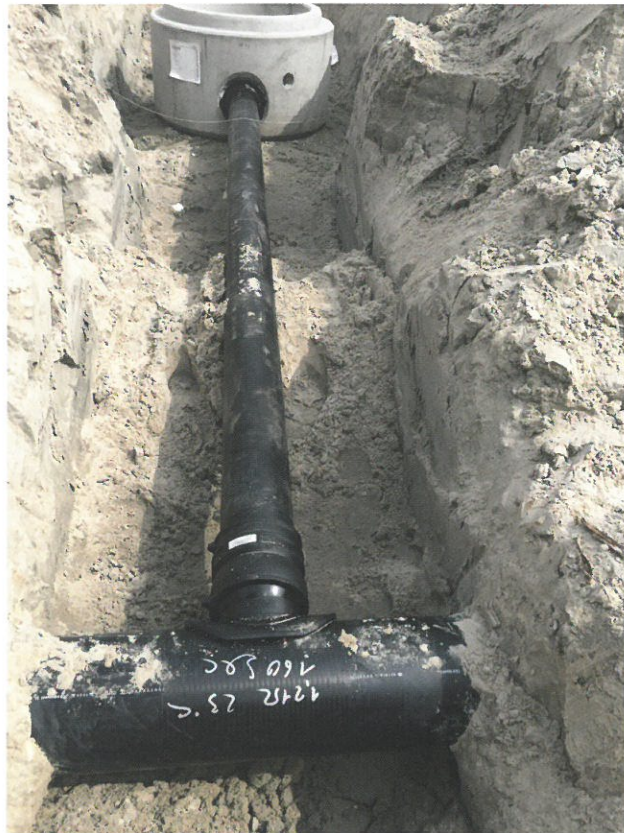
Bild 4: Vollgeschweißt bis zur Grundstücksgrenze: Die Grundstücksanschlussleitungen wurden mit dem PLASSON Betonschachtadapter und dem LightFit-Anschlusssattel mit flexibler Anschlussmuffe 0-12° zusammen geschweißt
