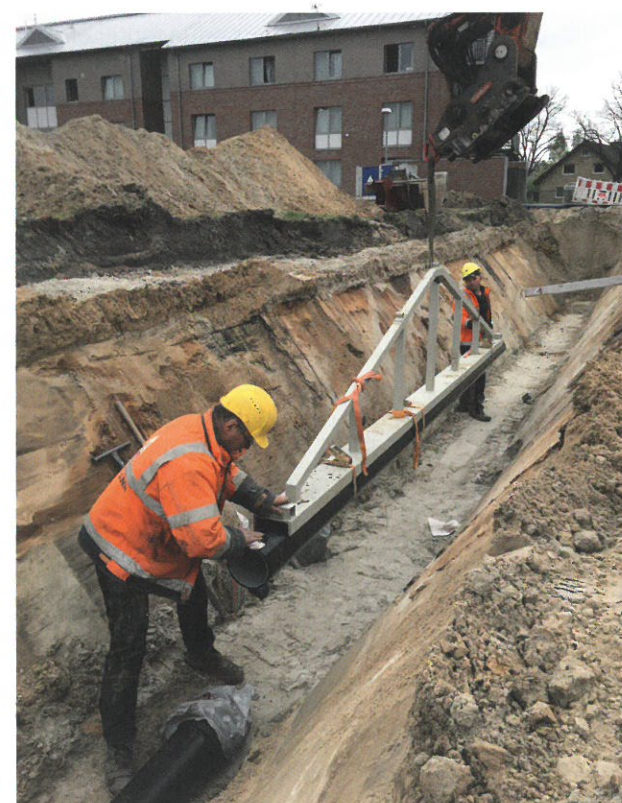
Bild 3: Verlegung der 6 m PE-HD-Kanalrohre durch die ARGE der Firmen Dallmann/Dieckmann
