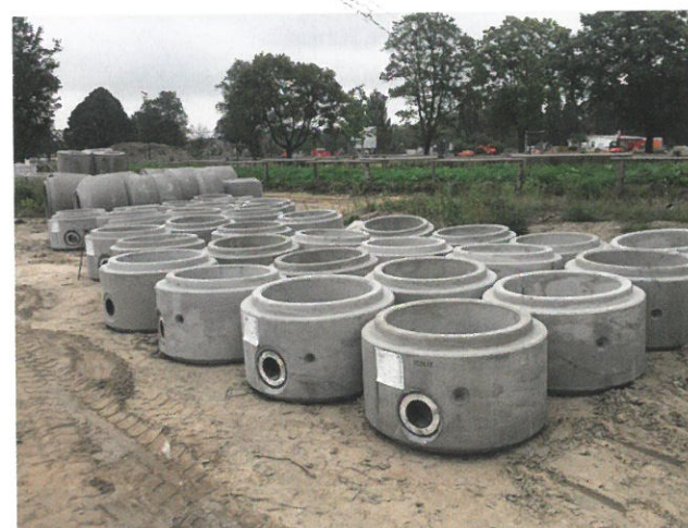
Bild 2: Warten auf Ihren Einsatz: Betonschachtunterteile DN 800 der Betonwerk Bieren GmbH mit integriertem PLASSON LightFit-Betonschachtadapter für die „vollverschweißte“ Anbindung der Schmutzwasserkanäle
