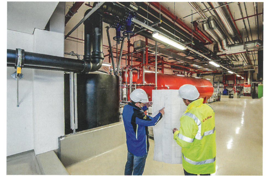
Bild 2: Martin Campen vom Ingenieurbüro VENS zeigt den Verlauf der verschweißten Kunststoffkältetrasse
