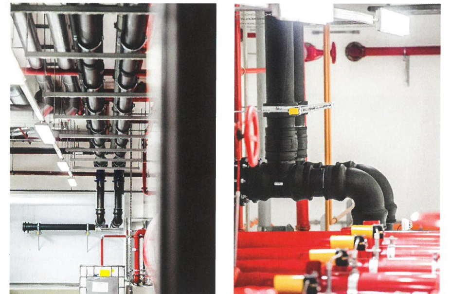
Bild 3: Verschweißte Kunststoffrohrleitung aus PE 100 RC Rohren und Plasson SmartFuse Elektroschweißfittings
