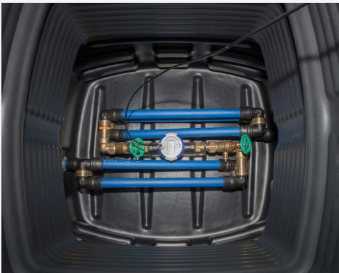
Abb.: 3 Anbringung des Kabels am Wasserzähler
