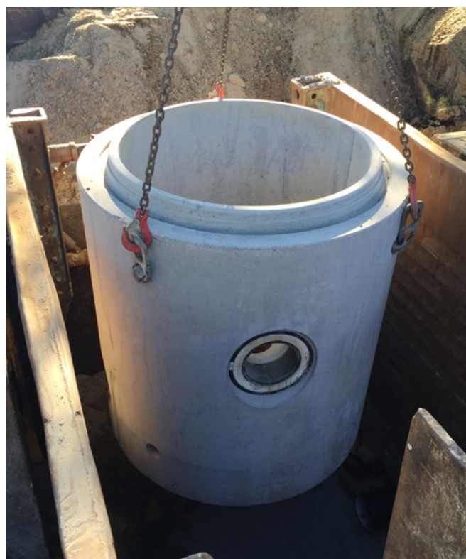
Bild 2: Die Paul Garbe Tiefbau GmbH im Einsatz. Absetzen eines Betonfertigteilschachtes mit bereits integriertem PE-Schachtanschluss in den Verbau und Ausrichten des Schachtkörpers
