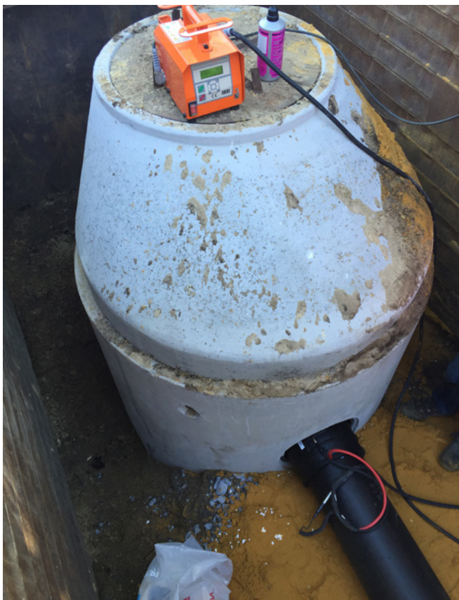
Bild 3: Verschweißte Verbindungen, Schachtanschluss-System (links) und Elektroschweißsätze (rechts) aus dem PLASSON LightFit-Abwasserprogramm
