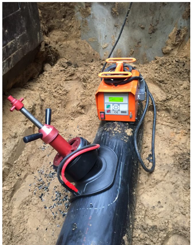
Bild 3: Verschweißte Verbindungen, Schachtanschluss-System (links) und Elektroschweißsätze (rechts) aus dem PLASSON LightFit-Abwasserprogramm
