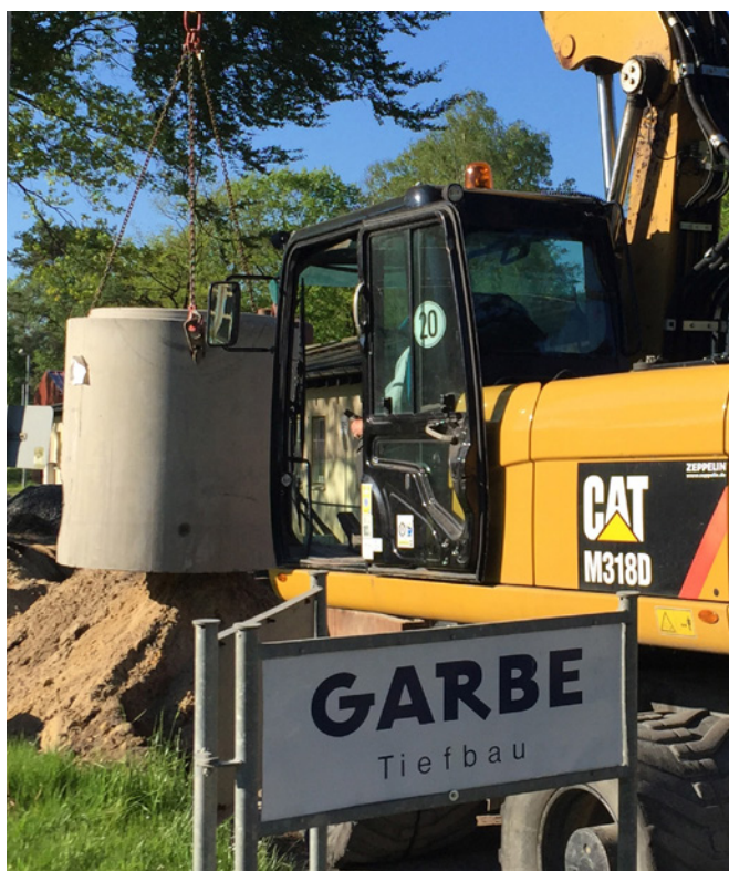
Bild 2: Die Paul Garbe Tiefbau GmbH im Einsatz. Absetzen eines Betonfertigteilschachtes mit bereits integriertem PE-Schachtanschluss in den Verbau und Ausrichten des Schachtkörpers
