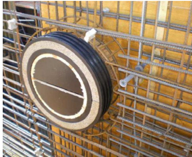
Bild 4: Baustellenmontage der PLASSON-LightFit-Betonschachtadapter
